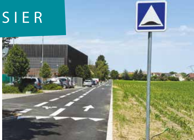
Travaux rue de la Garonne.
