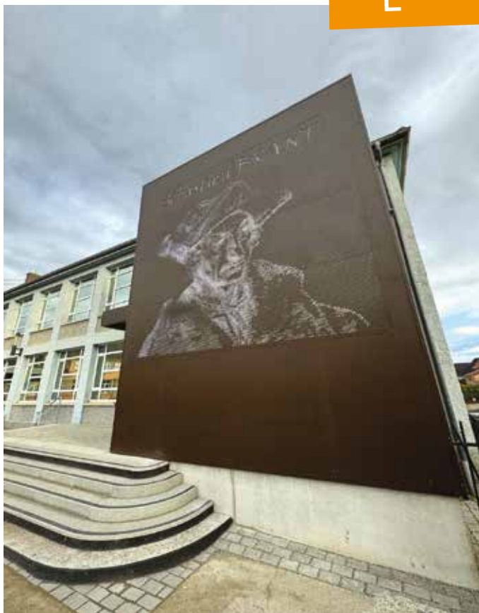
Escalier de secours de l'École Brant.
