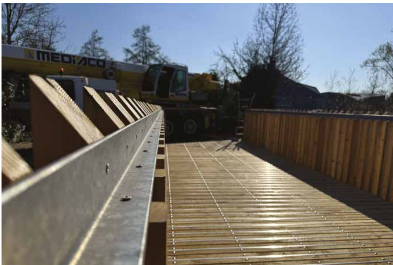
Passerelle piste cyclable entre l'école Veil et le Complexe sportif.
