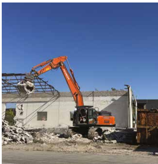
Démolition friche - 23 rue de l'Hôtel de Ville.
