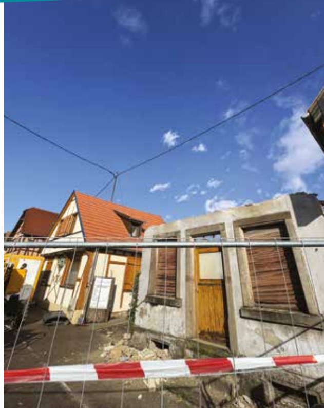
Démolition de friche - 15 rue du Maréchal Foch.
