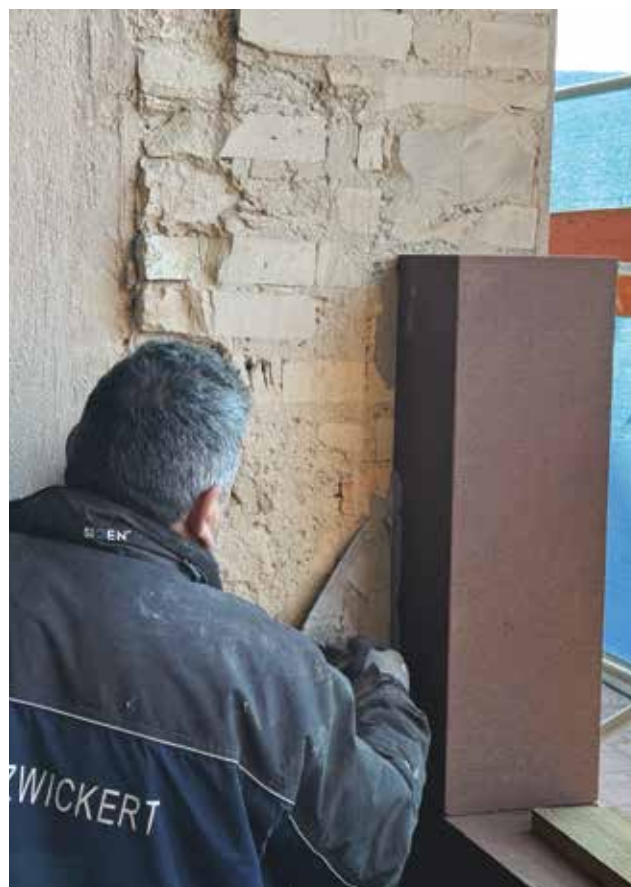
Travaux au tribunal.
