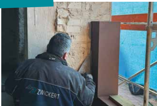
Travaux de rénovation de l'ancien Tribunal.
