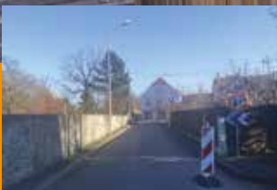
P 4 Chantier de la route d'Ohnheim
