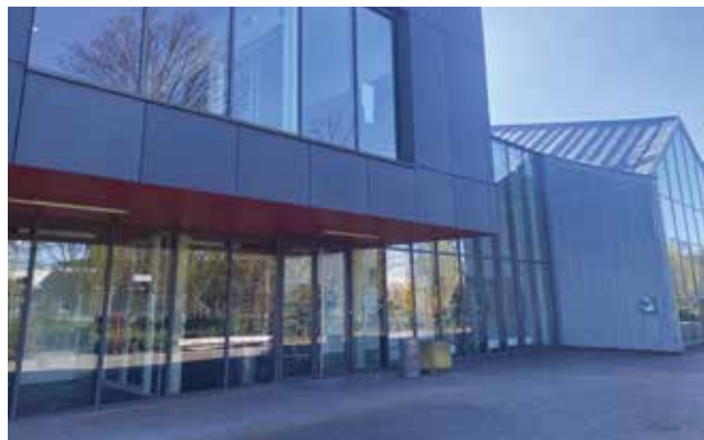
Extension du gymnase
