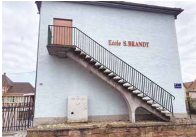
Escalier de secours
