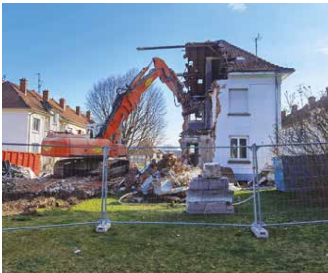
Démolition du bâtiment central de l'ancienne cité Douanière.
