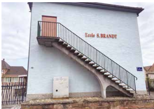
Escalier de secours
