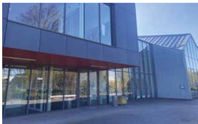
Extension du gymnase
