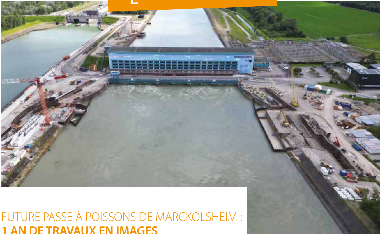
Vue aérienne du chantier le 12/06/24
