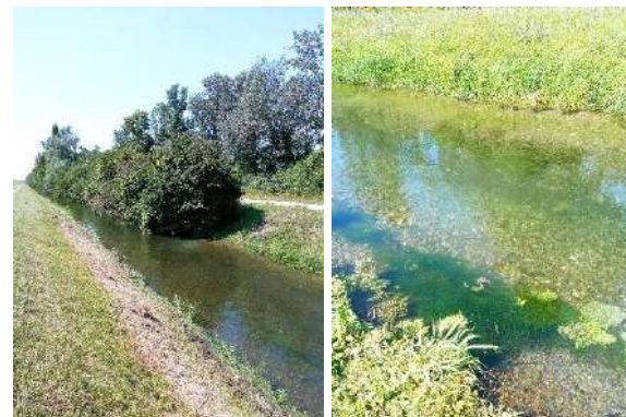
Photo 25 : Aperçu de la ZEI du contre canal
