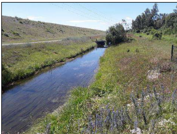
Photo 6 : Abords du contre-canal (Rainette, 2020)
